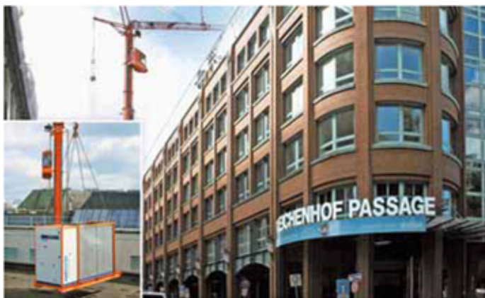
In der Hamburger Bleichenhof-Passage überbrückten die Betreiber den Ausfall der Klimaanlage mit Mietkälte.
