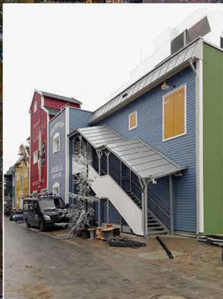
Das blaugraue Titanzinkdach über der Außentreppe passt hervorragend zur blauen Holzfassade
