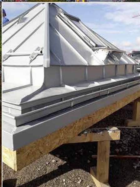
Die stehfalzgedeckten Hauben wurden am Boden montiert
