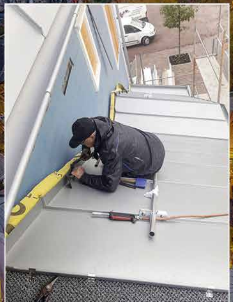
Die Anschlüsse an das Gefälle des Treppendachs sind Maßarbeit
