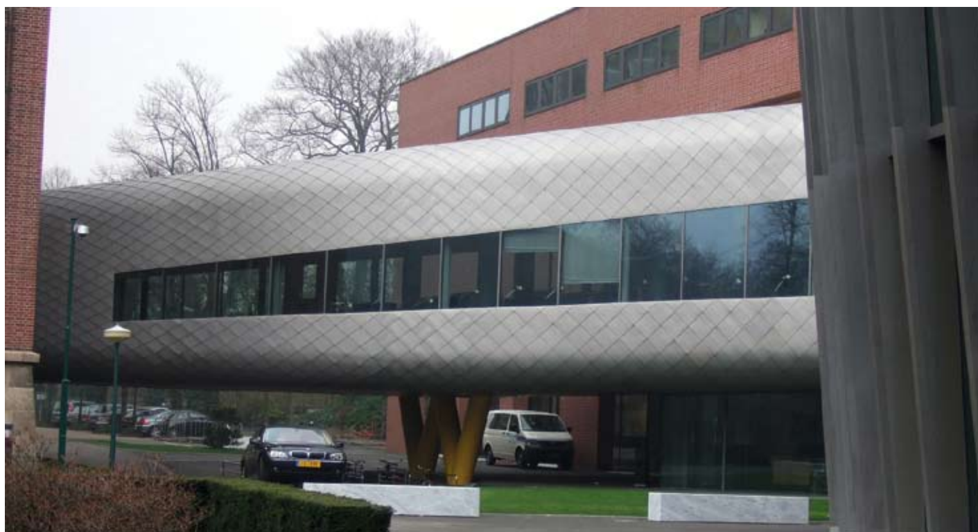
Vollständig eingehüllt in Rauten: Verbindungstrakt des Friedenspalast in Den Haag, Niederlande.
