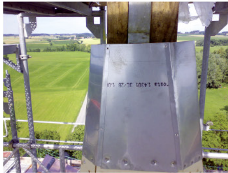
Frische Luft: Trauf- und Abschlussdetail mit ausgeklügelter Lüftungsöffnung
