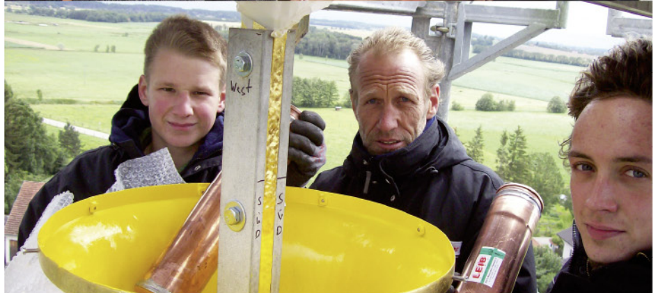
Verschlussache: Zeitdokumente verschwinden in verlöteten Kupferrollen. An der Turmkugel stehen Robert Keller, Adolf Heinzinger und Michael Leib
