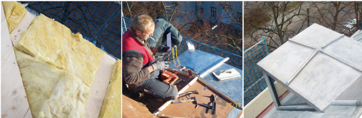
Nach Erhöhung des Gefälles der Gaubendächer setzten die Spengler Rundholzleisten im Nahtbereich ein
