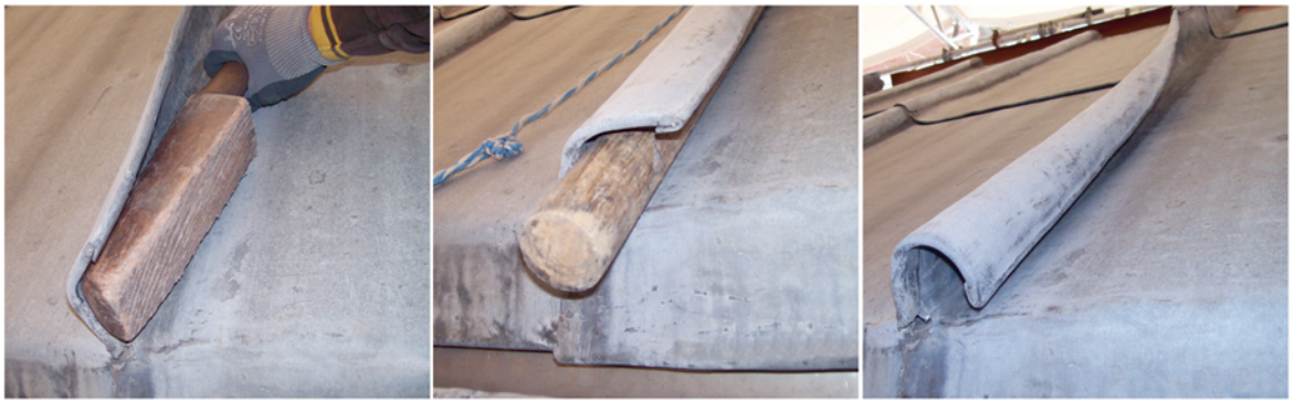
Die Herstellung der 60-mm-Rundfalze erfordert handwerkliches Geschick. Adolf Heinzinger verbindet einzelne Bleiplatten über entsprechenden Rundholzleisten. Das Gefälle der gewaltnen Gaubendächer wurde zuvor erhöht. Eine 27-mm-Dreischichtplatte dient als vollflächige Auflage für die neue Bleieindeckung
