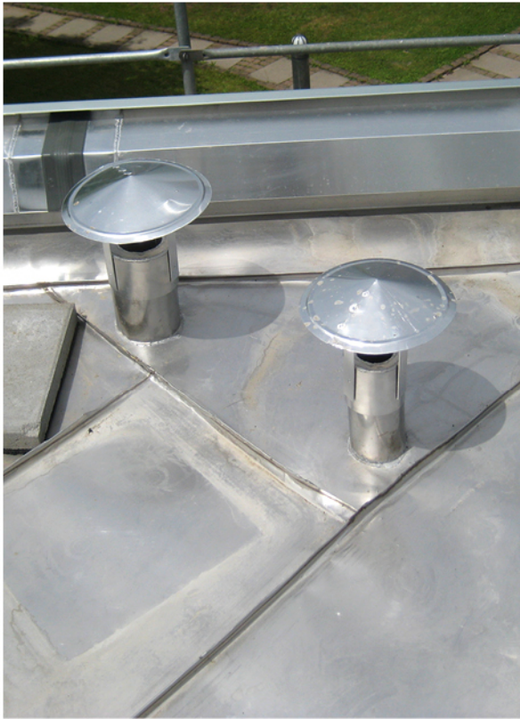
Sicher dank Edelstahl: zahlreiche Anschluss-Details und perfekte Attikausbildung
