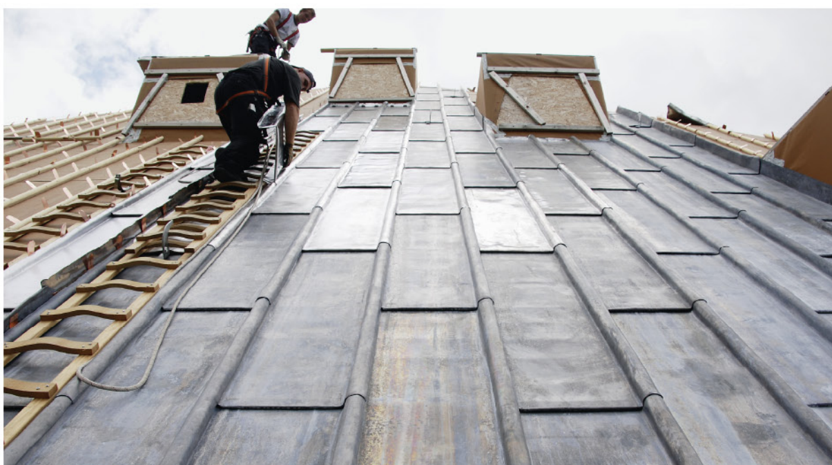
Die speziell angefertigten Dachleitern passen exakt zwischen die Wulste und bieten sicheren Halt. Selbstverständlich sind bei der 52° Dachneigung alle Mitarbeiter angesiebt
