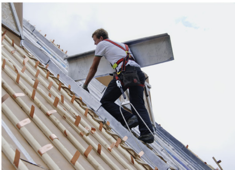
Auf der Unterkonstruktion sind die Holzwulste mit Haften aufgebracht. Die Bleipaneele sind zugeschnitten und abgekantet. Jedes Paneel wiegt etwa 40 kg
