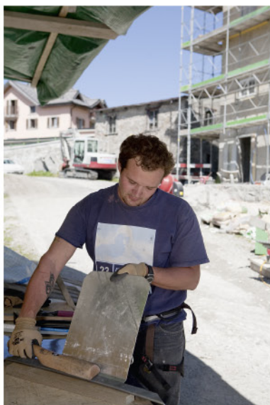
Vorbereiten der Blechteile für den Einbau
