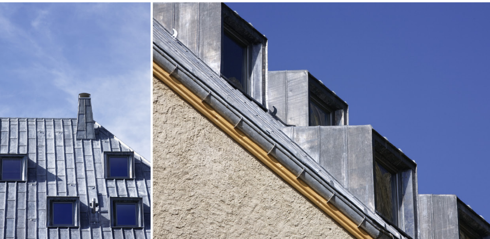
Das fertige Dach mit Abschluss, Regenrinne und den bleimhüllten Lukarnen
