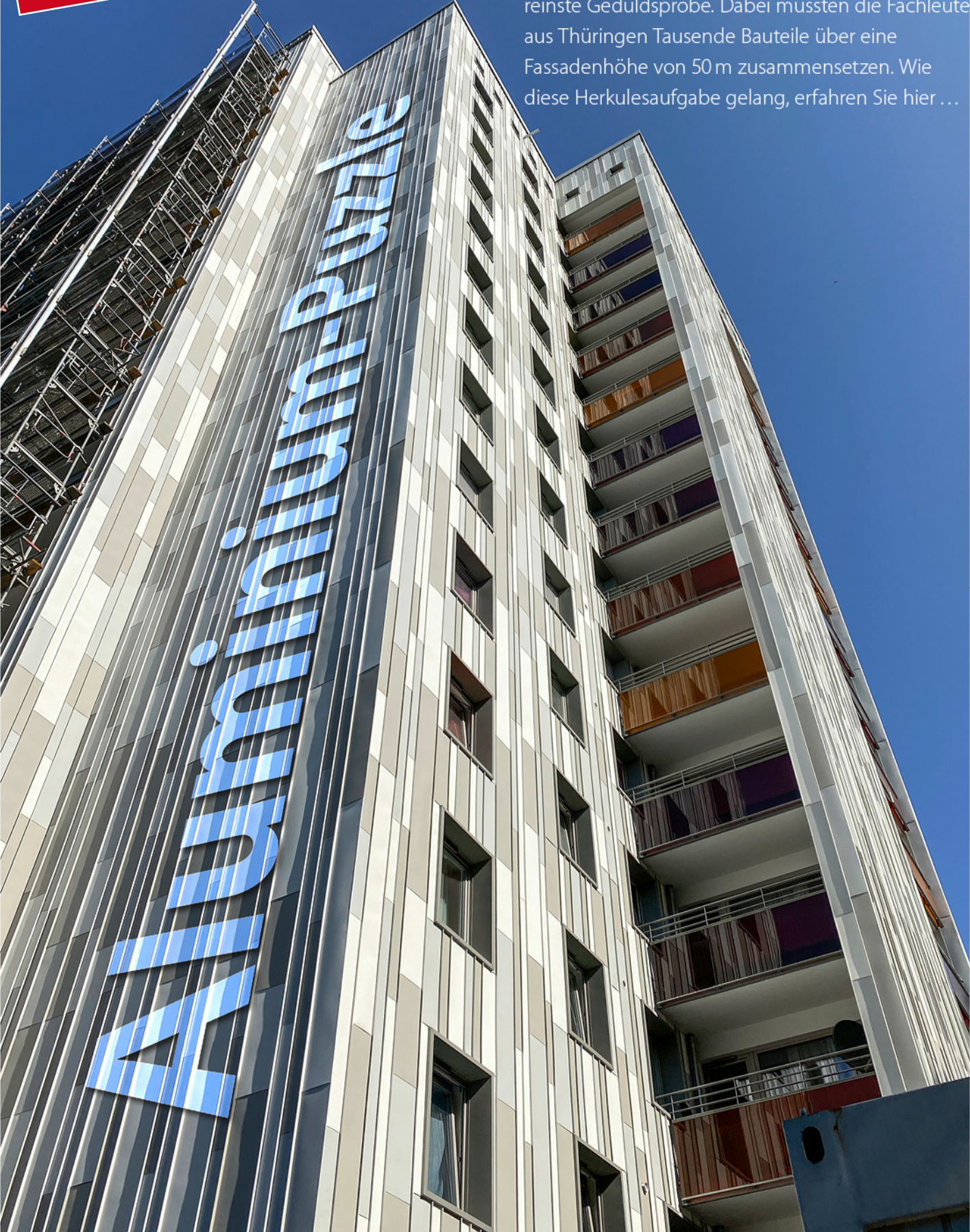
Wolkenkratzer mit Winkelfalz: Die Scharen strukturieren die Fassadenflächen und lockern diese durch dezente Farbwechsel gleichzeitig auf
