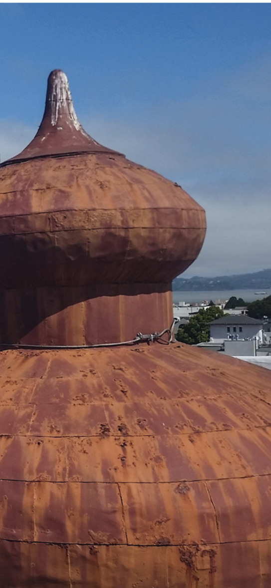
Kupferspezialist Liebscher nimmt eine zwiebelförmige Kuppel unter die Lupe
