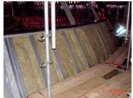
... wird zuerst Wärmedämmung zwischen Klemmprofile eingebracht ...
