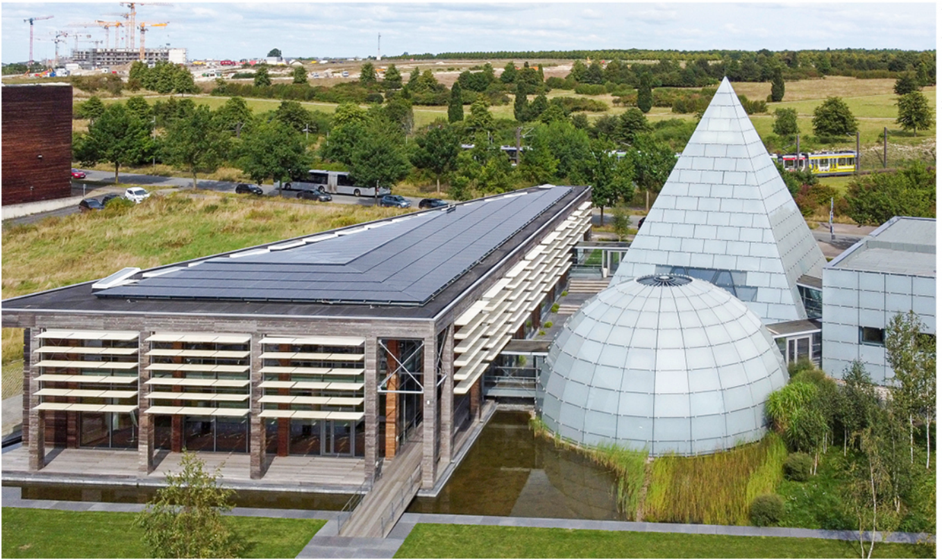
30 Jahre nach der Expo 2000 hat das Architektur- und TGA-Planungsbüro Carsten Grobe Passivhaus den Dänischen Pavillon in Hannover unter anderem mit einer PVT-Wärmepumpenanlage zum Plusenergiehaus modernisiert.
