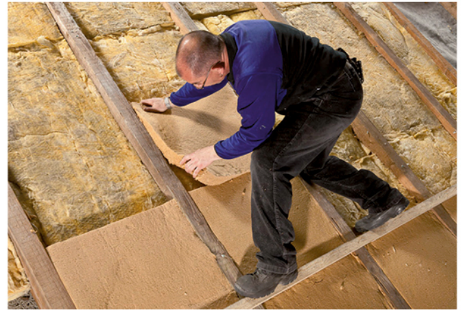
6 Bei der flächigen Verlegung der Luftdichtung auf den Sparren können vorhandene Dämmstoffe im Gefach verbleiben.
