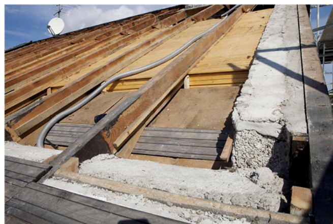
4 Optimale Voraussetzung für die Sub-und-Top-Dachsanierung: eine einfache Dachstruktur und parallel angeordnete Sparren. Diese Variante wird in der Praxis am häufigsten gewählt.
