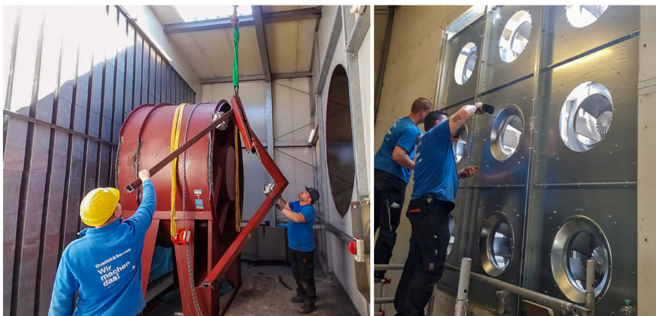
Optimierung einer RLT-Anlage bei einem Automobilhersteller in Berlin: Der Ventilator wurde zerlegt und mit einem Kran durch das Dach abtransportiert, das zuvor von einem Dachdecker geöffnet worden war. Anschließend wurde eine Ventilatorenwand („Fanwall“) als Grundkonstruktion zur Aufnahme energieeffizienter Ventilatoren mit EC-Motoren eingebaut.
