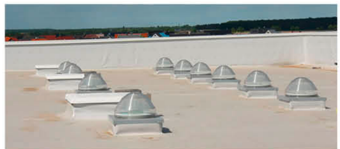
3 Egal ob Flach- oder Steildach und unabhängig vom Bedachungsmaterial: die Prismenkuppel integriert sich unauffällig in die Dachlandschaft und leitet ein Vielfaches dessen an Tageslicht in ein Gebäude, was durch ein Dachflächenfenster gleicher Größe in den Raum zu gelangen vermag.
