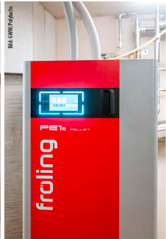
Der Holzpelletkessel mit 45 Kilowatt Leistung heizt, wenn keine oder zu wenig Solarwärme erzeugt wird.
