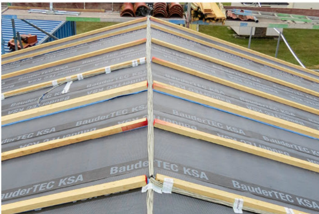
4 Konstruktion A des Freilandversuchs: Montage der diffusionssperrenden Unterdachbahn mit Konterlattung und Temperaturfühlern.
