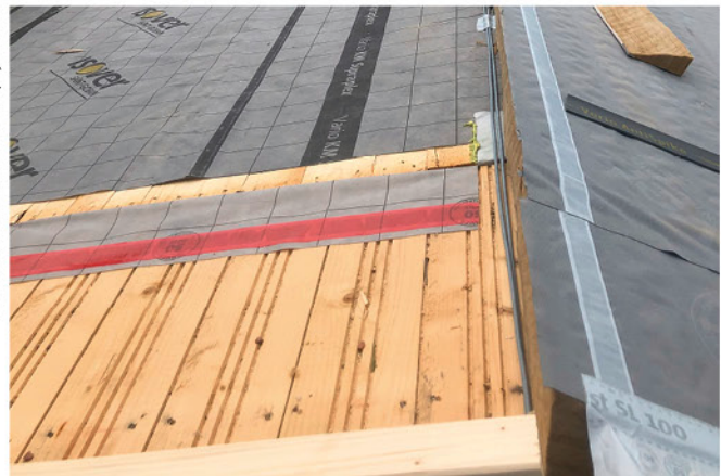
5 Dachkonstruktion mit dem Aufbau B: Auf der linken Dachhälfte die feuchtevariable Dampfbremse Vario KM Supra Plex-SKS auf Holzschalung, rechts ist bereits die Aufsparrendämmung mit aufkaschierter Unterdeckbahn Ultimate AP Supra Plus aufgebracht.
