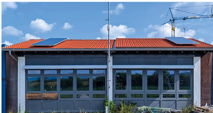
6 Fertig eingedecktes Dach des Versuchsaufbaus mit Zwischensparrendämmung (Konstruktion A, links) und Aufsparrendämmung (Konstruktion B, rechts)
