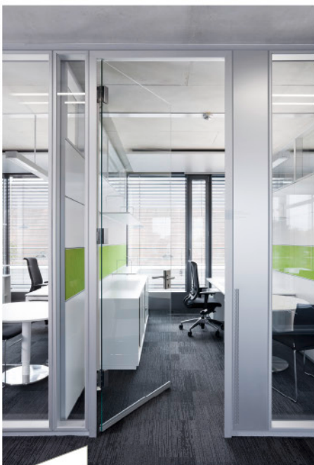
Die Systemtrennwände sind mit akustisch wirksamen Überströmelementen ausgestattet. Vertikale Luftüberströmelemente sind in die geschlossenen nur 250 mm breiten Türseitentelle integriert.
