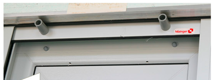
Auch kleinformatische Fenster erhalten Entlüftungsbohrungen im oberen Fensterblendrahmen.
