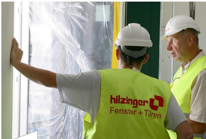
Helmut Hilzinger legt höchste Ansprüche an die Montage der Fensterelemente und verschafft sich vor Ort ein Bild von der Einbausituation.
