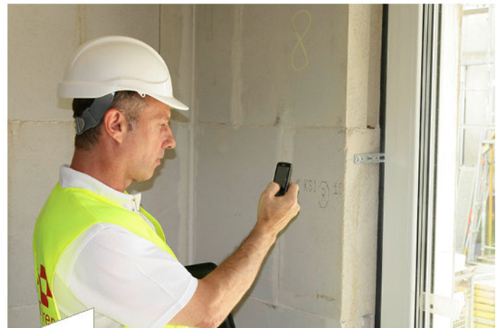
Projektleiter Kai Mätz hat die Logistik und Qualitätssicherung im Griff. Bei der Baustelle Westarkaden kam es vor allem auf die Sicherheit an.
