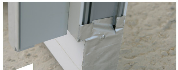
Vor Einbau werden offene Stirnflächen sorgfältig verklebt, damit Wasser oder Feuchtigkeit nicht in die Konstruktion eindringen kann.
