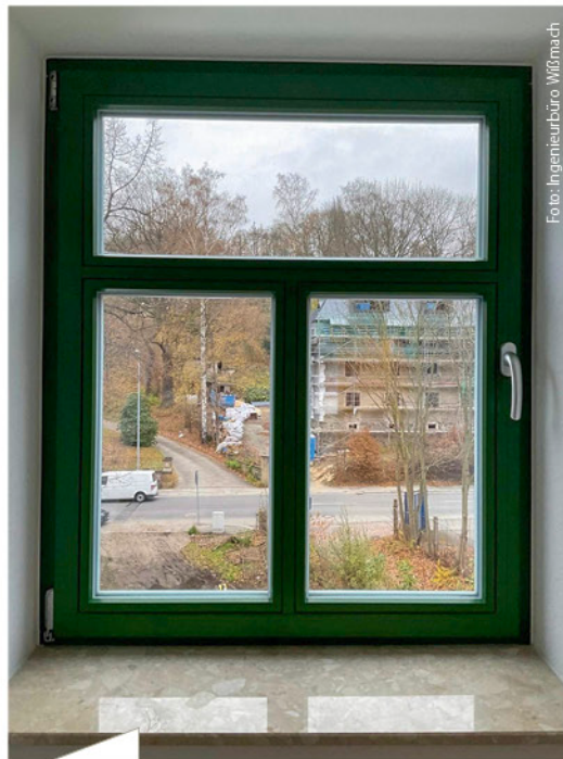
Beispiel eines sanierten Holzfensters im denkmalgeschützten Gebäude an einer stark befahrenen Straße.
