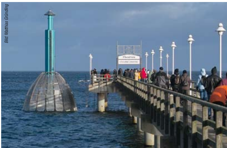
Die Haube der Tauchgondel ragt immer aus dem Wasser heraus. Hier befindet sich die Anlagentechnik, unter anderem ein GEA-Zentrallüftungsgerät mit Elektroheizung. Die Kabine aus Stahl und Glas könnte bis zu 20 m tief tauchen, in Zinnowitz sind es jedoch nur 4 m bis zum Meeresgrund.
