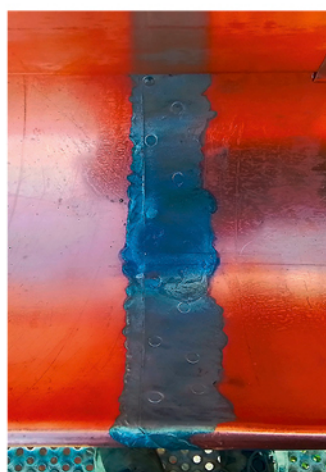
Die nach historischer Vorlage gefertigten Rinnenstützen sowie die Rinnennähte wurden mit Vollnieten verbunden und weich gelötet
