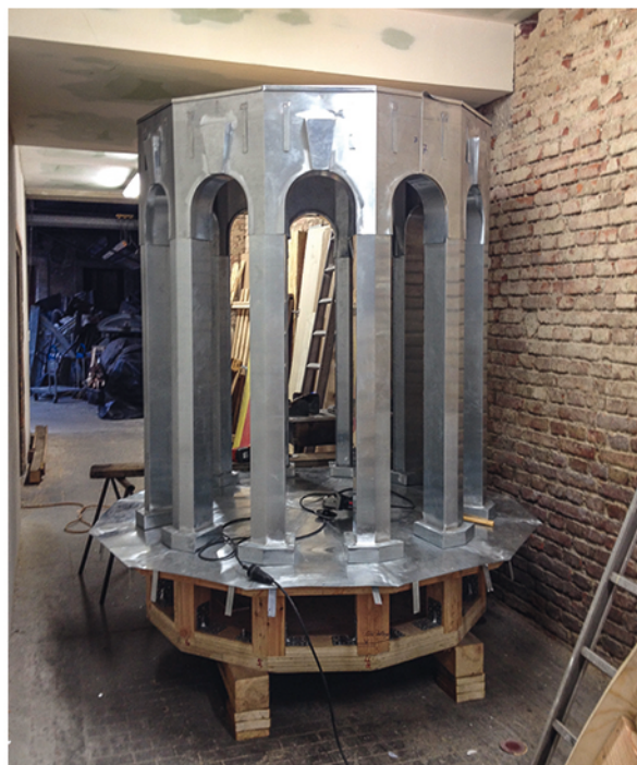
An den Bögen wurden trapezförmige Schlusssteine platziert
