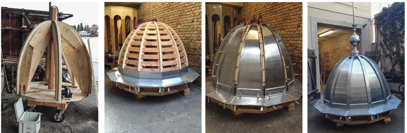
Vier Fertigungsschritte von der hölzernen Unterkonstruktion bis zur Zink bekleideten Kuppel
