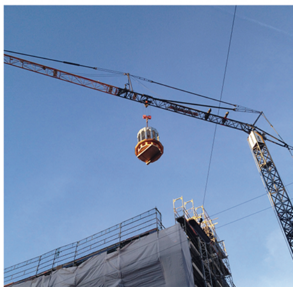
Der Transport auf das Dach erfolgte per Baukran
