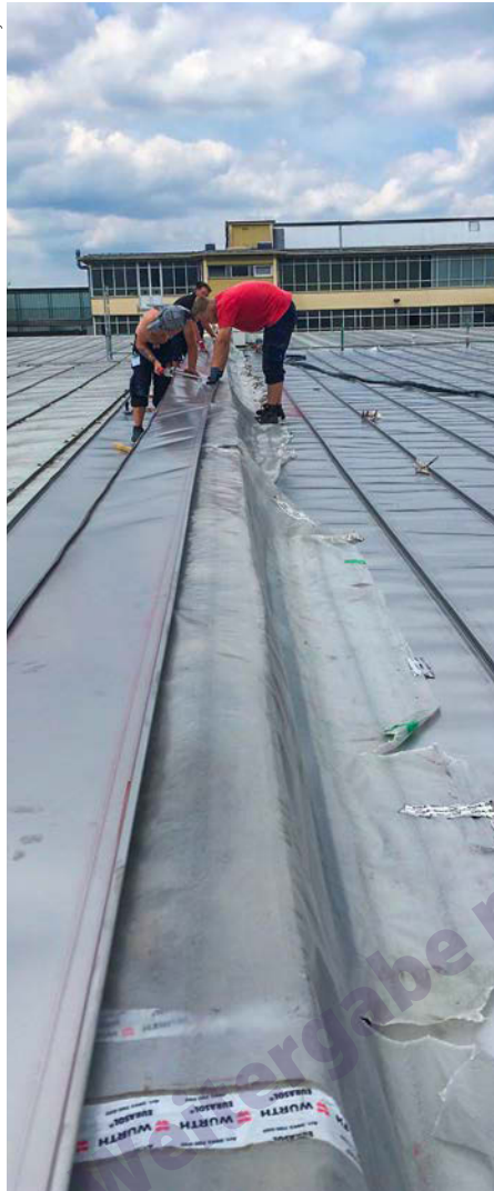
Montage eines rollnahtgeschweißten Edelstahldachs
