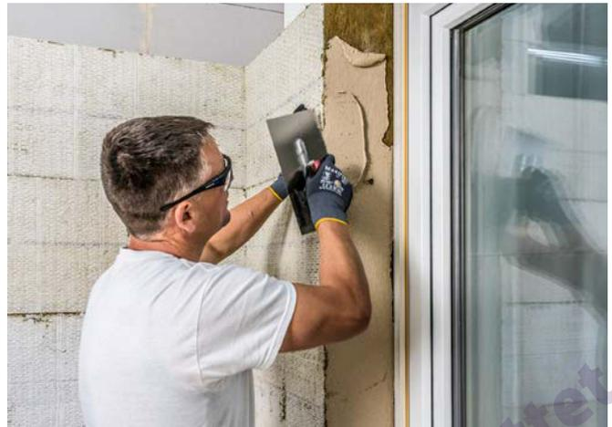
Vorbeschichtete Leibsplatten werden im Buttering-Floating-Verfahren auf den Dämmstoff aufgebracht.
