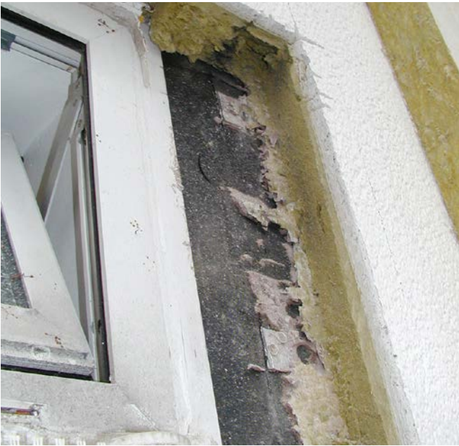
Bauteilöffnung im Bereich der Fensteranschlüsse
