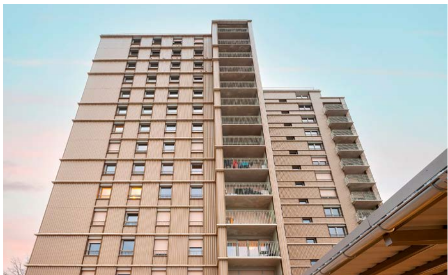
Ein 14-stöckiger freistehender Plattenwohnturm im Südosten von Regensburg gilt als Vorzeigebispiel für eine nachhaltige Generalsanierung.
