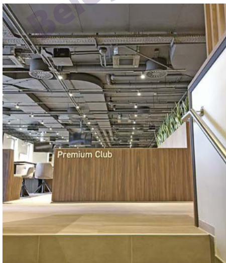
Die von KlimaShop! schwarz lackierten Deckenkassetten fügen sich harmonisch in das Gesamtbild ein.
