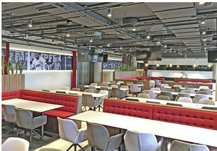
Eine Zentralfernbedienung steuert die Deckenkassetten, die sich in den unterschiedlichen Bereichen im Gebäude befinden.
