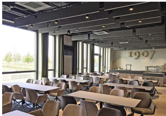
Die Komfortpaneele im 1907 Club sorgen für eine optimale Luftverteilung und reduzieren Zugluft.
