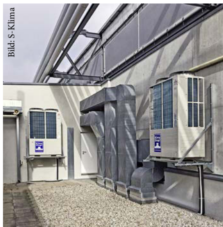
Die Außengeräte wurden mit einem Kran an ihren Aufstellungsort gebracht.
