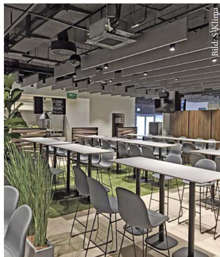
Das Klimasystem reduziert die hohe punktuelle Luftfeuchte, welche durch Erwärmen von Speisen entsteht.
