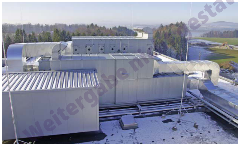
Lüftungsaggregat auf dem Dach der Käserei Gebr. Woerle.
