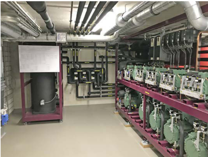
Blick in den Maschinenraum
