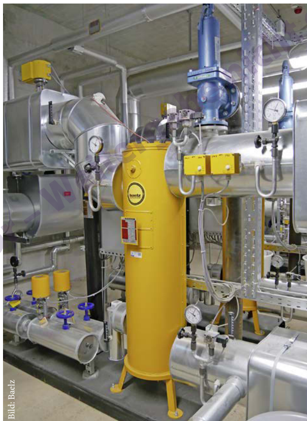
Bild 1: Dampf-Wasser-Übergabestation in Verbindung mit der übrigen Gebäudetechnik
