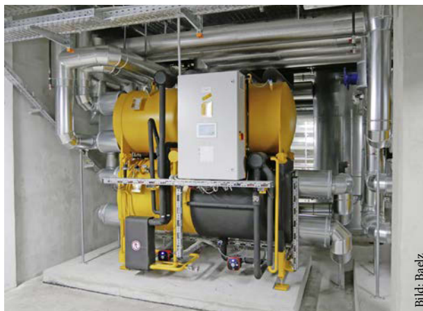
Bild 2: Absorptionskälteanlage Hummel
