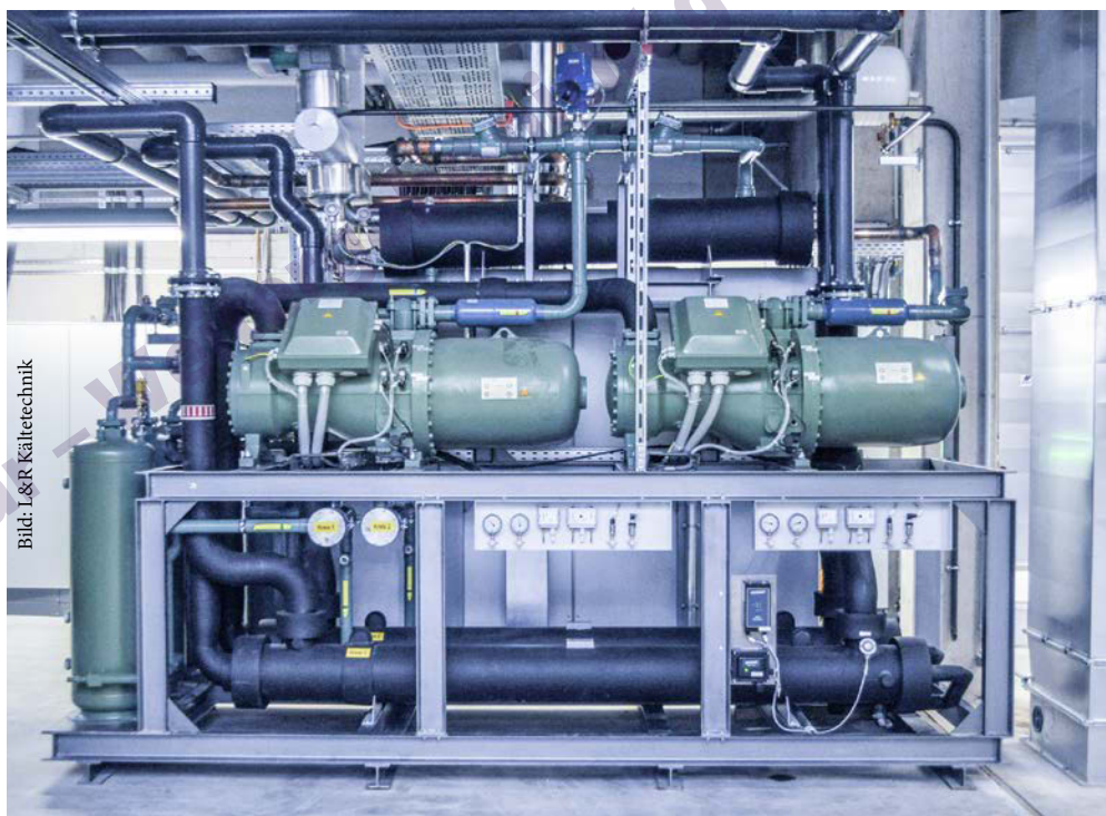
L&R projektierte für Spies insgesamt vier 300 kW-Kälteanlagen der Serie ECOPRO 2.0 für die Werkzeug- und eine 470 kW-Anlage für die Hydraulikkühlung. Alle Anlagen sind mit dem HFO-Blend R 513 A befüllt.
