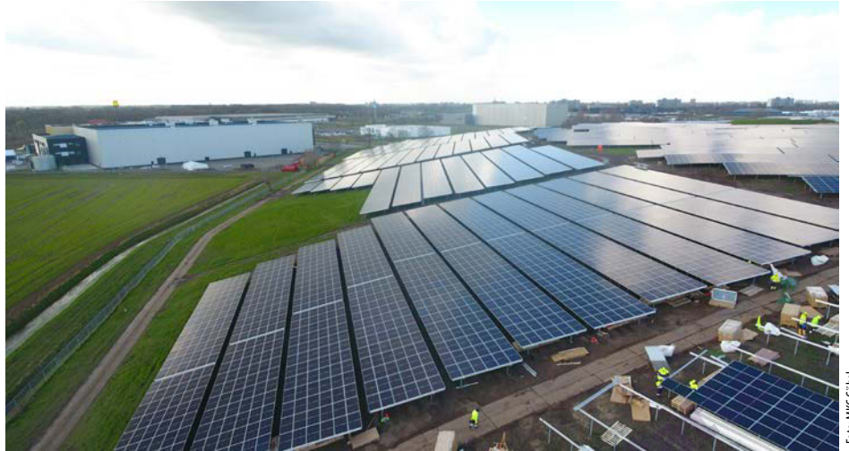
Die Neigungen der Hänge von Mülldeponien sind sehr unterschiedlich. Hier ist es von Vorteil, wenn das Montagesystem leicht anzupassen ist.
