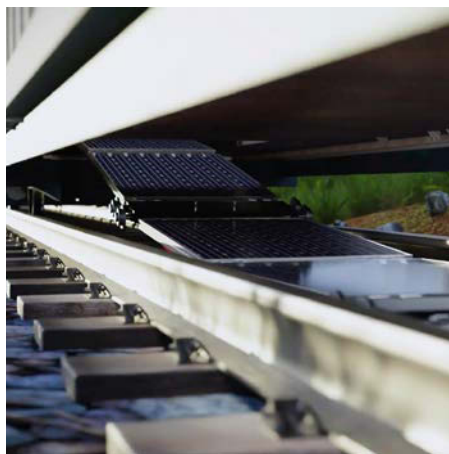
Module werden quasi wie ein Teppich zwischen den Schienen ausgerollt.
