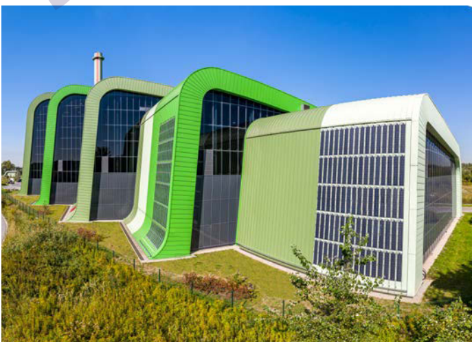
Eine echte Augenweide: Solarfassade an der Müllverbrennungsanlage in Krakau in Polen.
