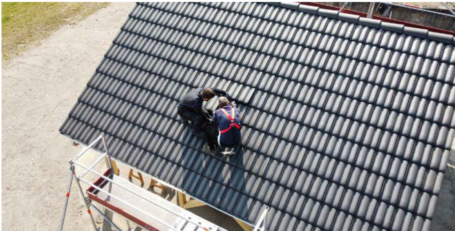
Um die Dächer mit Solarmodulen zu füllen, schulen viele große Handwerksbetriebe wie hier Wirsol Handwerker für die Photovoltaikinstallation um.
