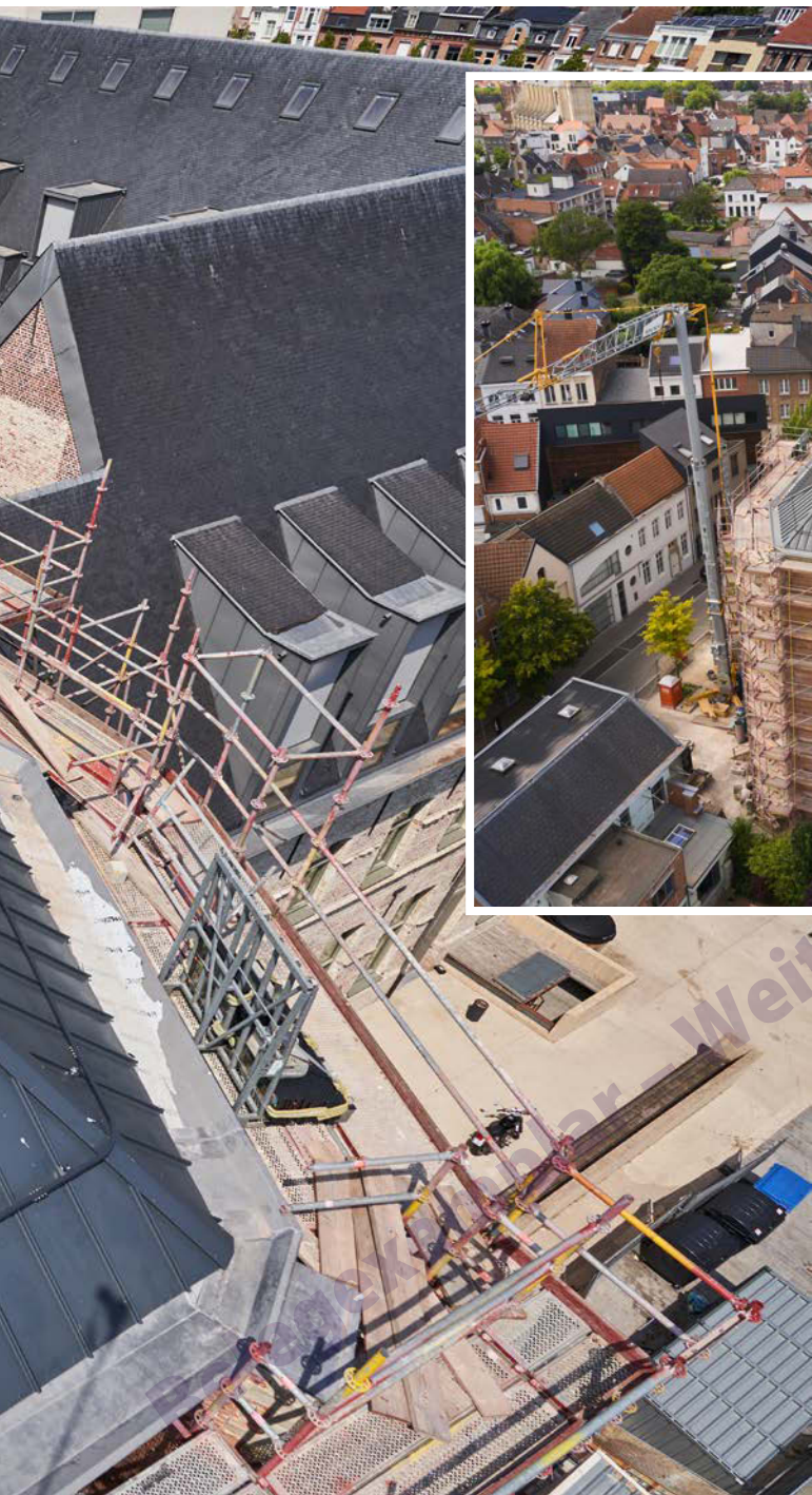
Das Kloster in Mechelen während der Bauphase.
