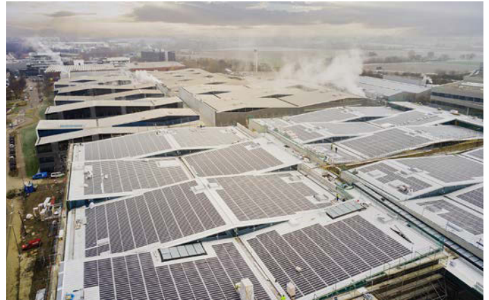
Die Anlage bei Trumpf leistet 1,14 Megawatt.
