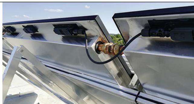
Doppelter Anschluss: PVT-Module wandeln die Sonnenstrahlen gleichzeitig in Strom und Wärme. Sie können Wärmepumpen zweifach mit Energie versorgen.
