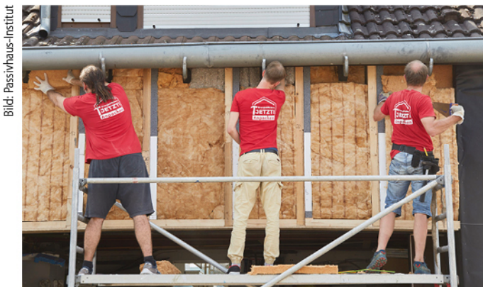
Die Anbringung einer Außendämmung ist anspruchsvoll, kann aber dennoch von den Hauseigentümer:innen in Eigenarbeit ausgeführt werden.
