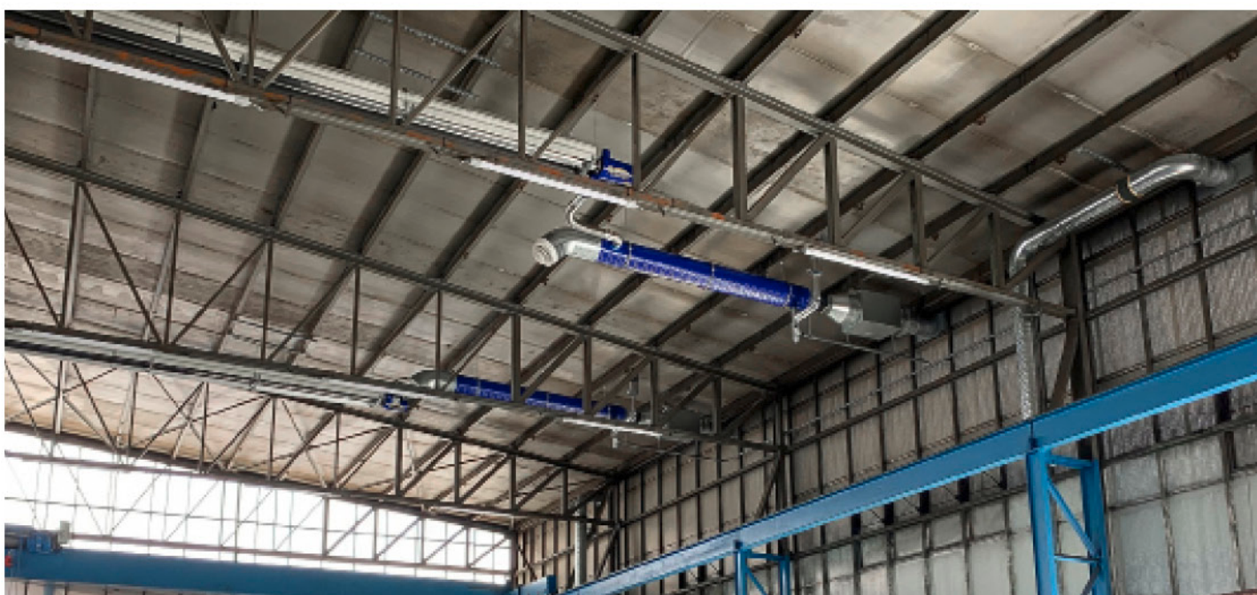
In der Halle in Leipzig ergänzen Dunkelstrahler im Gebäudeinneren die Solarkollektoren an der Außenfassade.
