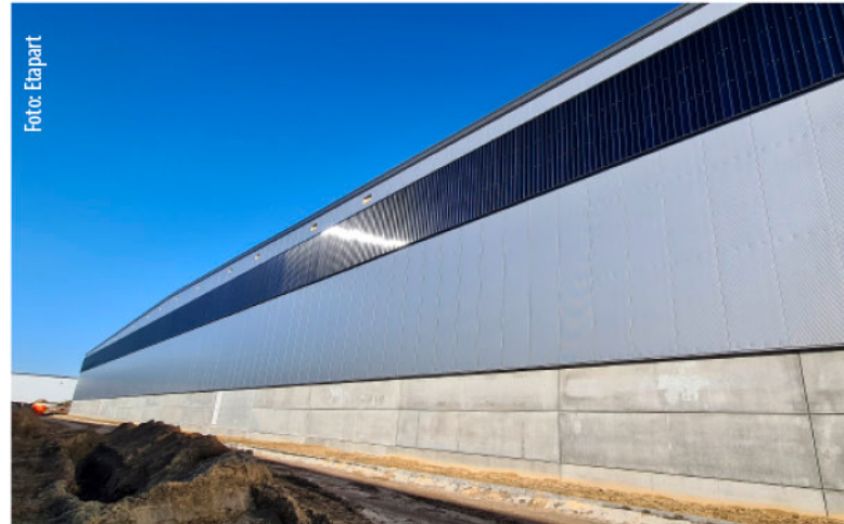
Solarluftkollektoren an einer Logistikhalle in Fürstenwalde
