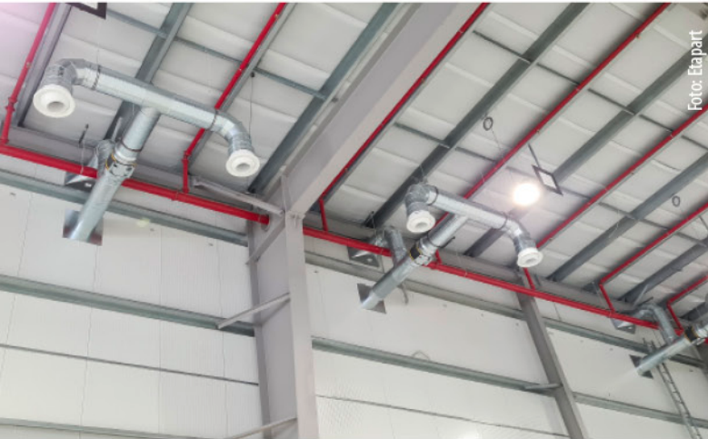
Deckenauslässe für die warme Luft in einer Logistikhalle in Fürstenwalde
