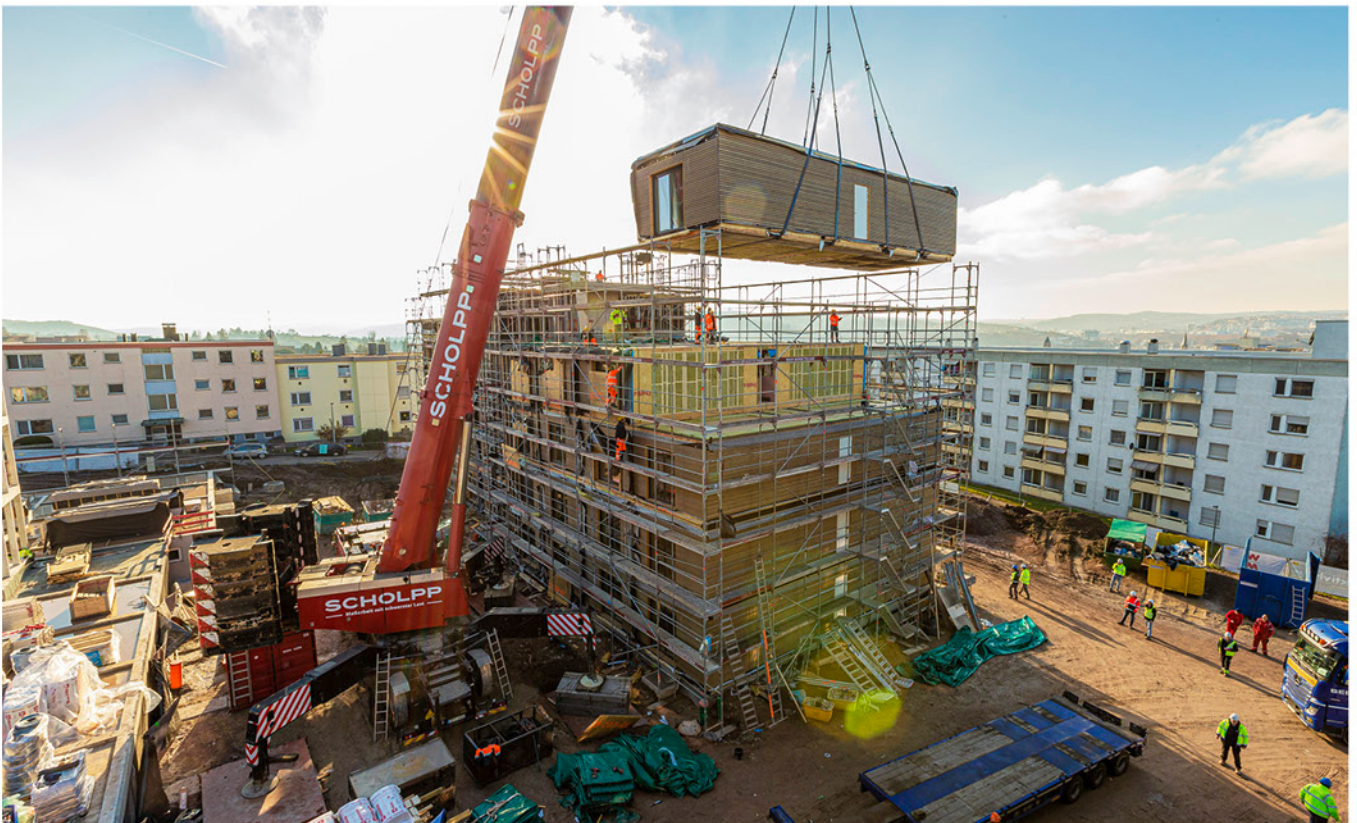
Die Holzmodule kommen mit einem Vorfertigungsgrad von bis zu 95 Prozent auf die Baustelle und werden in 30 Minuten eingebaut.
