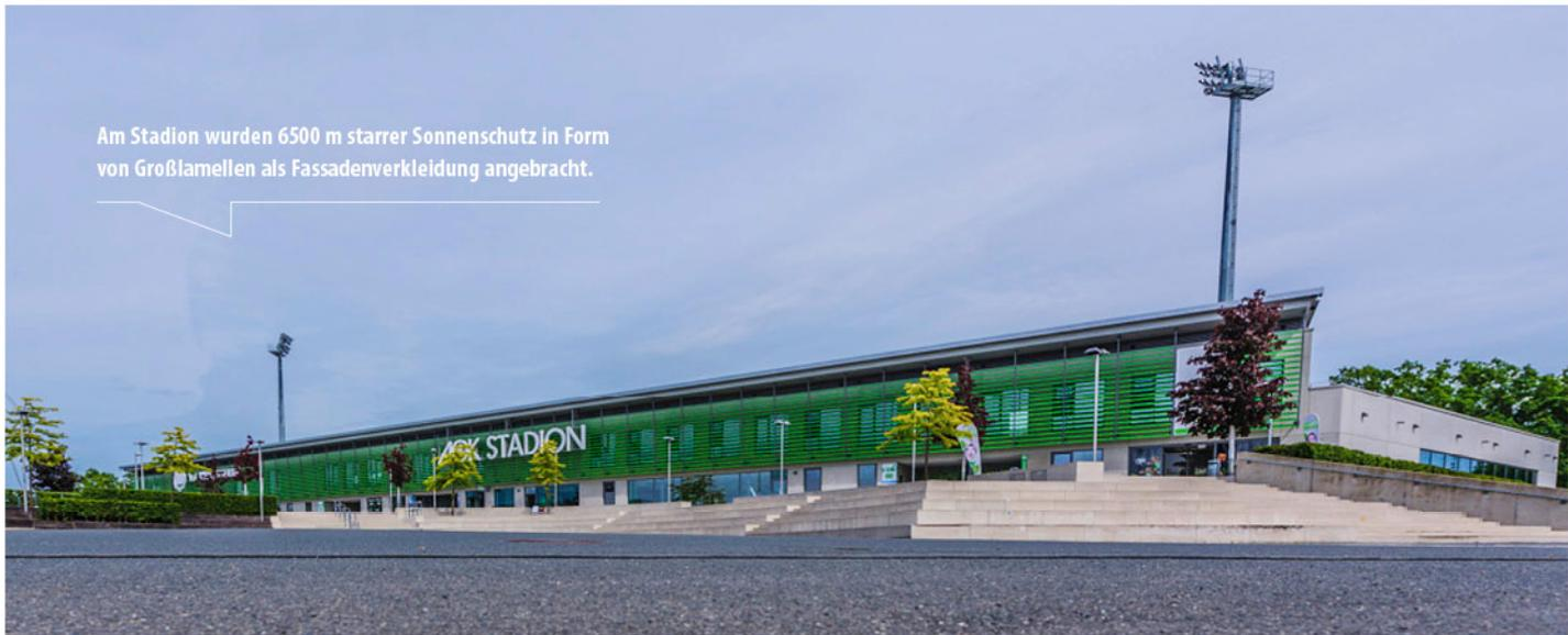
Am Stadion wurden 6500 m starrer Sonnenschutz in Form von Großlamellen als Fassadenverkleidung angebracht.
