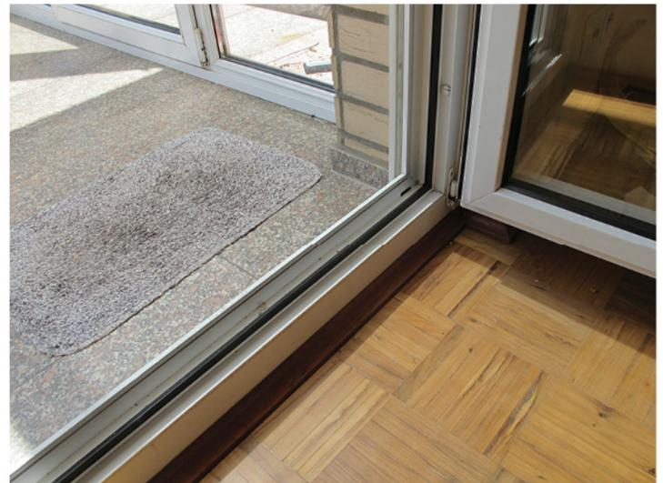
Nach dem Umbau ist der Durchgang zum Wintergarten gegeben, da die Höhe der Schwelle entsprechend für die Rollatornutzung (< 2 cm) reduziert wurde.
