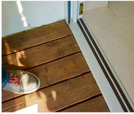
„Die schwellenfreie Magnet-Doppeldichtung funktioniert im Betreuten Wohnen der Stiftung Espachstift bereits seit 2001 zuverlässig.“ so Ernst Schönhaar.
