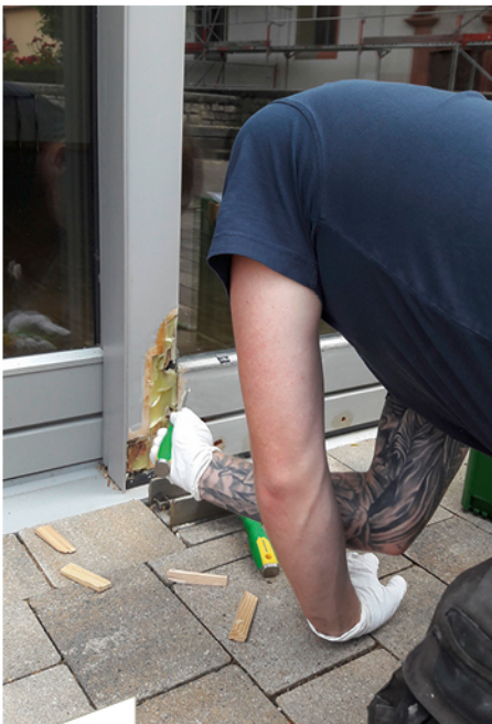
Bild 4: Neuaufbau mit Holzersatzmaterial
