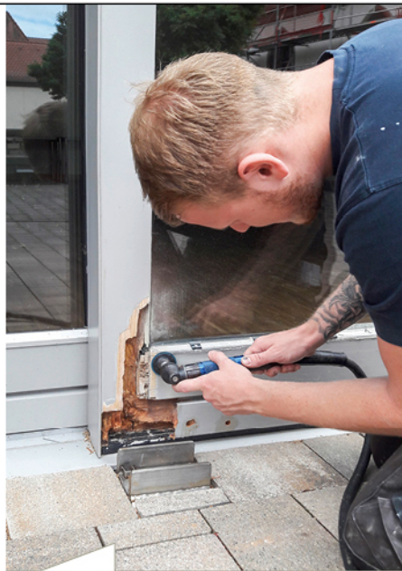
Bild 3: Entfernung der schadhaften Teile
