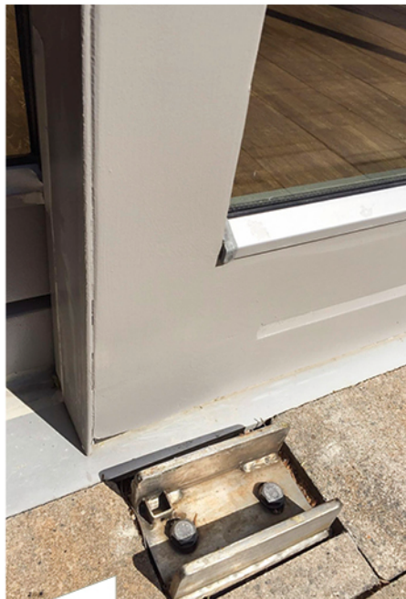
Bild 5: Balkontür fertig saniert
