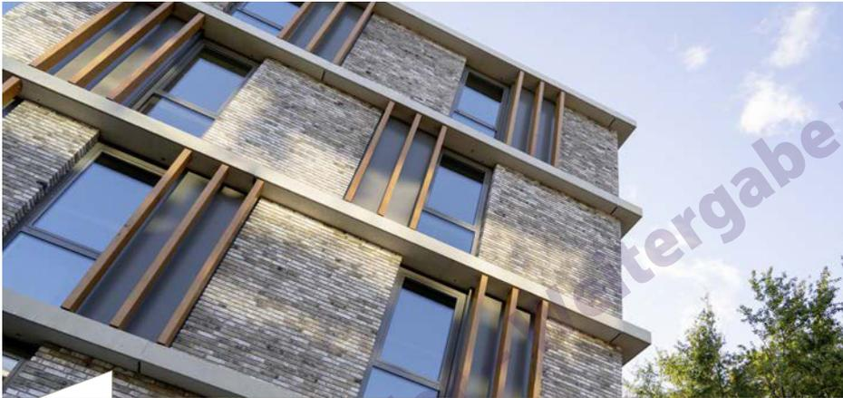
**Die mehr als 1500 Holzsäulen an der Fassade werden durch das Remmers Holzschutzsystem Induline GW-310 vor Wind und Wetter geschützt.**
