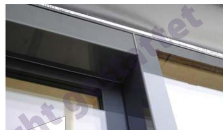
Das Stufenisoliertglas überdeckt außen die Holzprofile.
