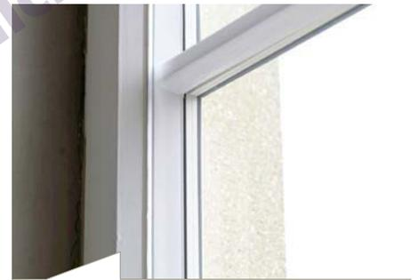
**Saubere Kopplung der Wiener Sprosse auf der Sichtfläche des Abstandhalters. Die Sprosse liegt ohne Spalt auf und die Mittellinie ist in einer Flucht mit der Mittellinie des Abstandhalters.**
