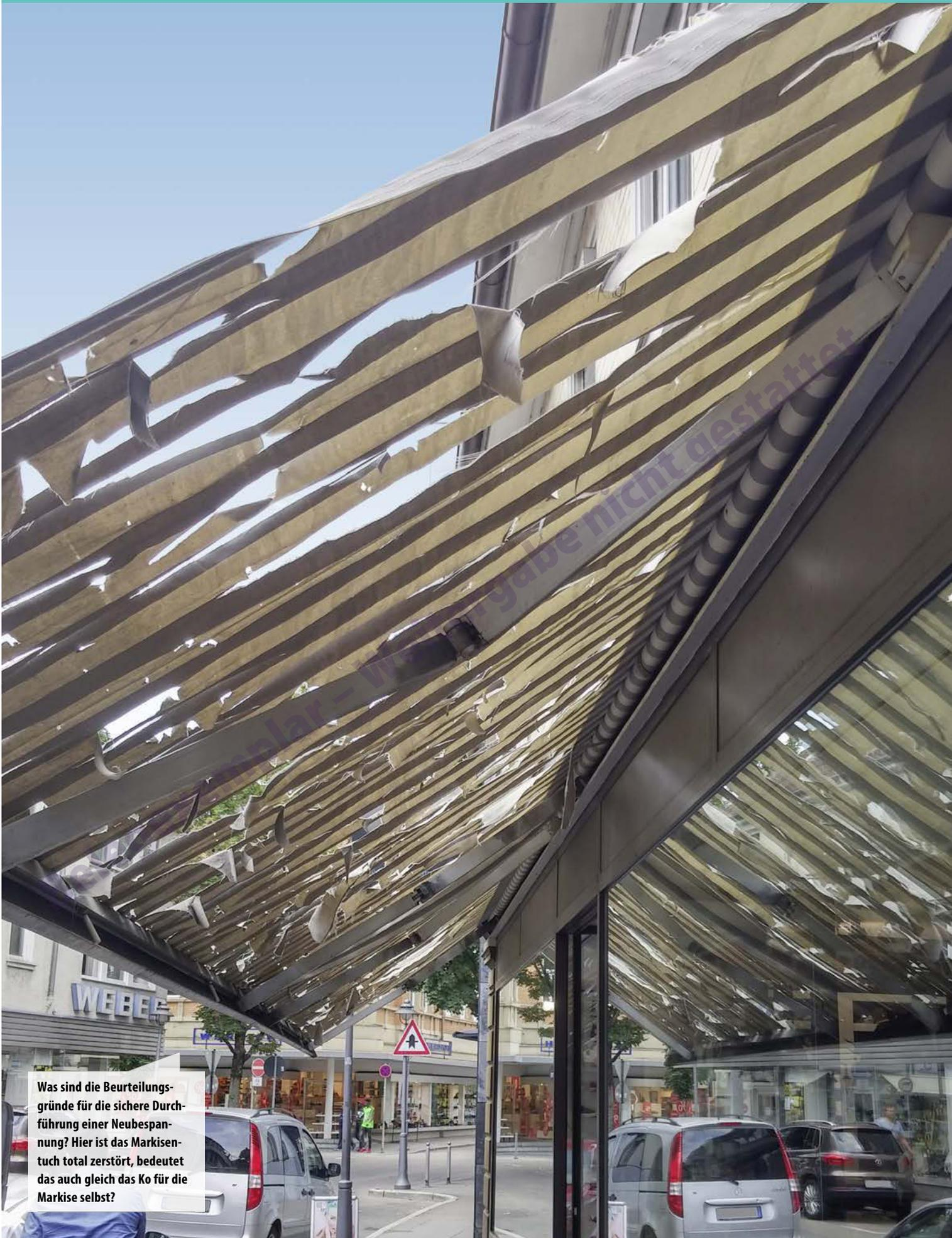
Was sind die Beurteilungsgründe für die sichere Durchführung einer Neubespannung? Hier ist das Markisentuch total zerstört, bedeutet das auch gleich das Ko für die Markise selbst?
