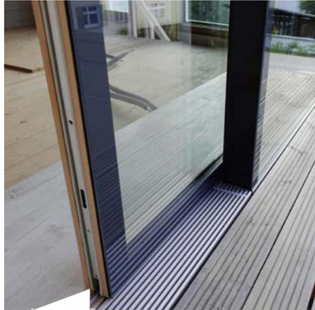
Das Glas wurde mit Ködiglaze S von H.B. Fuller | Kömmerling mit der Fensterkonstruktion verklebt.
