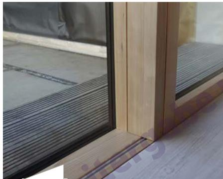
Die Hebe-Schiebe-Tür aus Holz-Aluminium wurde schwellenfrei ausgeführt ...
