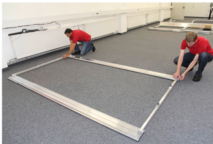
Im Competence Center von IBC Solar. Die Monteure Andreas Ullrich und Tobias Zipf nutzen eine Montagelehre zum Ausrichten der Bodenschienen.
