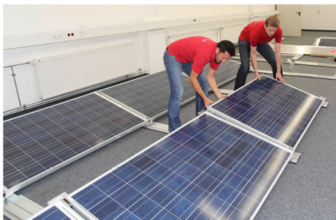
Endspurt bei der Montage mit dem AeroFix 15. Jetzt fehlt nur noch ein Modul. Das sieht nach einem Rekord aus.
