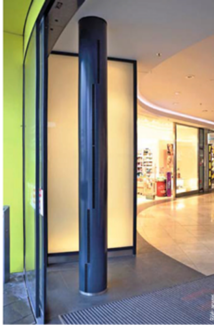
3 arvus-Luftschottanlage am Eingang eines Einkaufsmarktes. Jede Anlage wird nach den Kundenanforderungen und den örtlichen Gegebenheiten konstruiert.
