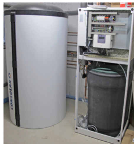
3 Im Monitoring betreute Solink-Anlage mit 40-m 2 -PVT-Kollektorfläche (links) und Komponenten (Kombispeicher, Wärmepumpe und Eisspeicher) (rechts).
