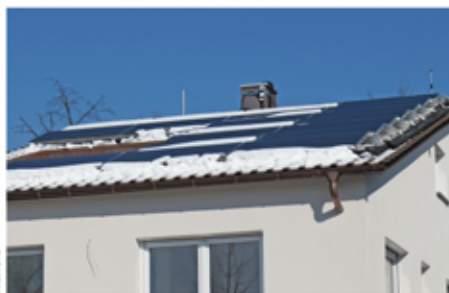
3 Im Monitoring betreute Solink-Anlage mit 40-m 2 -PVT-Kollektorfläche (links) und Komponenten (Kombispeicher, Wärmepumpe und Eisspeicher) (rechts).
