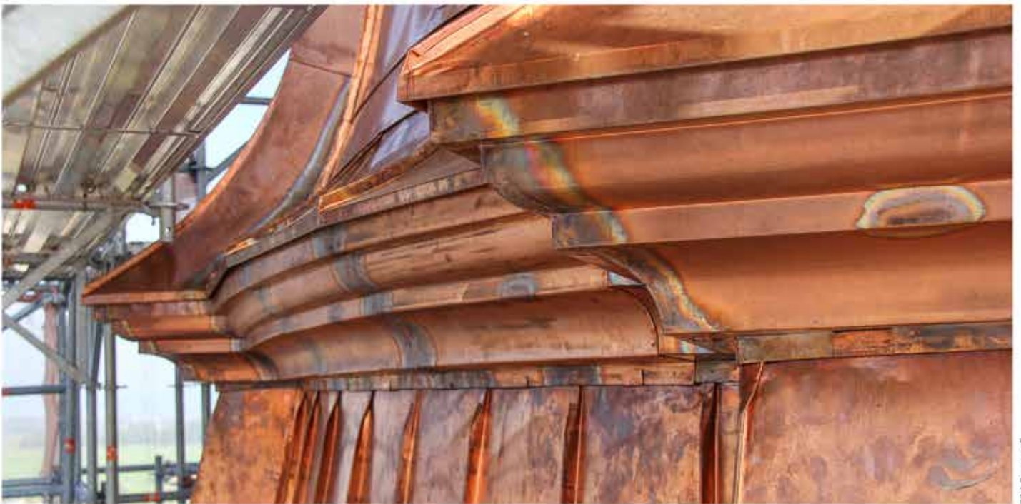
Übergang: Von der unteren Zwiebel aufsteigende Scharen greifen unter das abgetrepte Sockelgesims der Laterne
