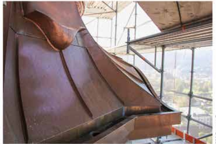
Am Lisenenabschluss befinden sich wappenförmige Zieraufsätze. Diese wurden bei Kaufmann in Neu-Ulm originalgetreu nachgebaut
