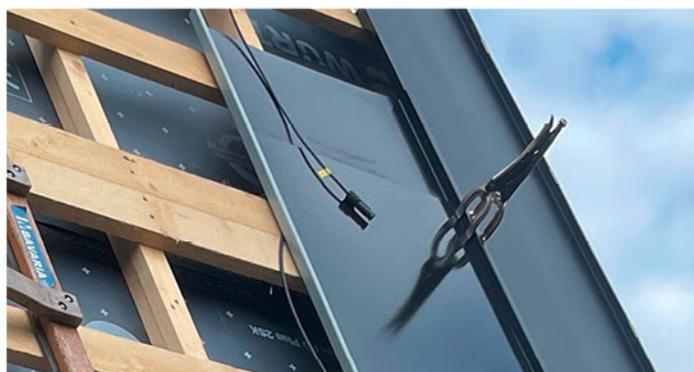
Steckfertig vorkonfektionierter Anschluss des Roofit.Solar-Elements
