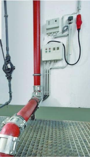
Bild 2 Fotos von der Druckleitung einer Abwasserhebeanlage aus gusseisernen Abflussrohren
