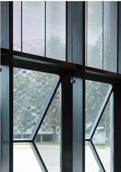
**8, 9** Im bodennahen Bereich an der Südfassade fallen die prismenartige Verglasungen ins Auge – diese sogenannten parametrischen Glaselemente gewährleisten eine ausreichende Verschattung und erlauben trotzdem die Sichtbezüge zwischen innen und außen.
