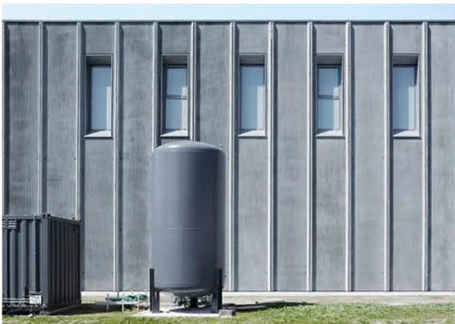
**11** Fassade und Dach des modular zusammengesetzten Gebäudes sind thermisch aktivierbar: Den äußeren Abschluss der Hüllkonstruktion bilden 5 cm schlanke hinterlüftete Fassaden- und Dachplatten aus mikrobewehrtem, ultrahochfestem Beton. Innen wie außen ist oberflächennah ein Rohrleitungsnetz aus Polypropylen eingelegt, in dem Wasser zirkuliert.
