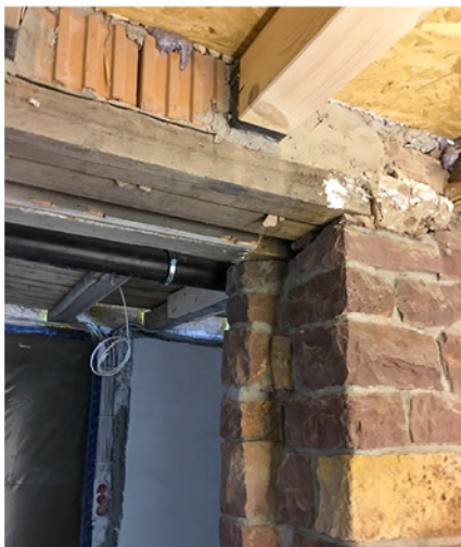
5 Bei diesem Bruchsteinmauerwerk waren Luftströmungen messbar, was den Architekten zu unglaublichem Staunen veranlasste.
