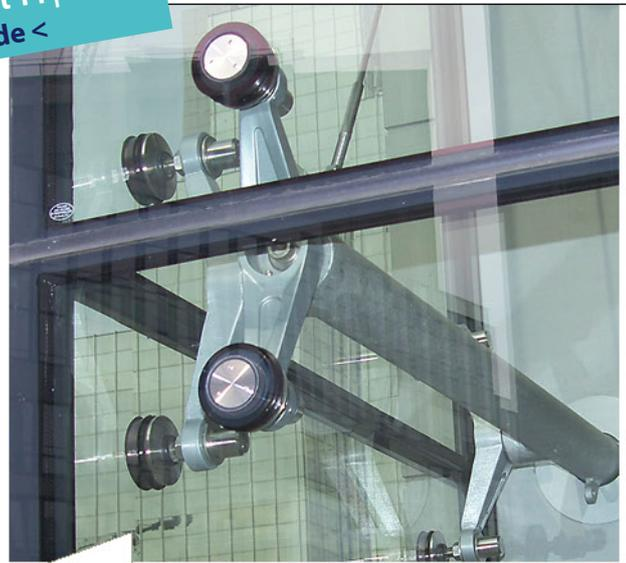
Bei den Aufzugverglasungen des Skylight-Centers in Frankfurt sind die Isolierglashalter ZK CI 46 70 von gebo im Einsatz.
