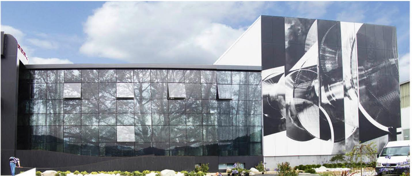
Bei dieser Glasfassade erstreckt sich das im Foliendruck umgesetzte Bild über 84 Einzelscheiben. Bei der Umsetzung des Drucks war höchste Genauigkeit gefordert.
